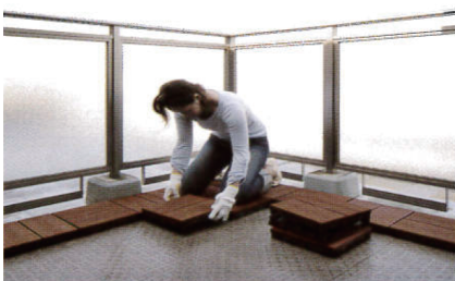
外周から設置し、順々に中に設置します
