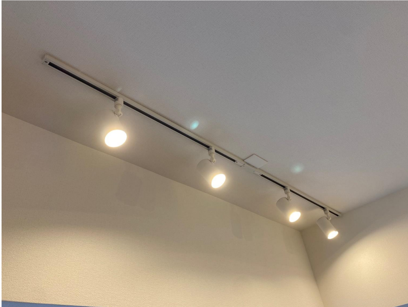
LED照明新設
