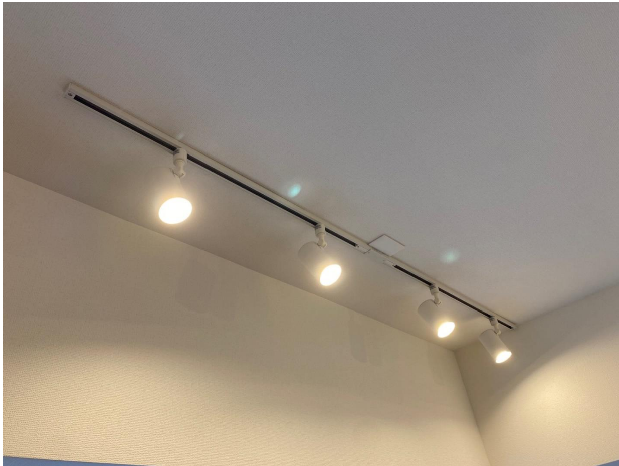
一部LED照明新設
