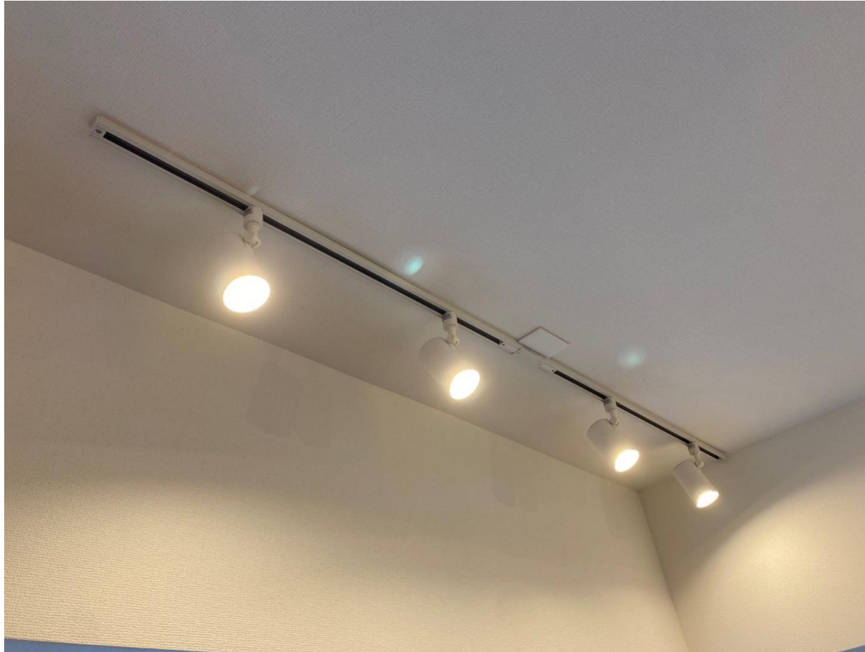
LED照明新設
