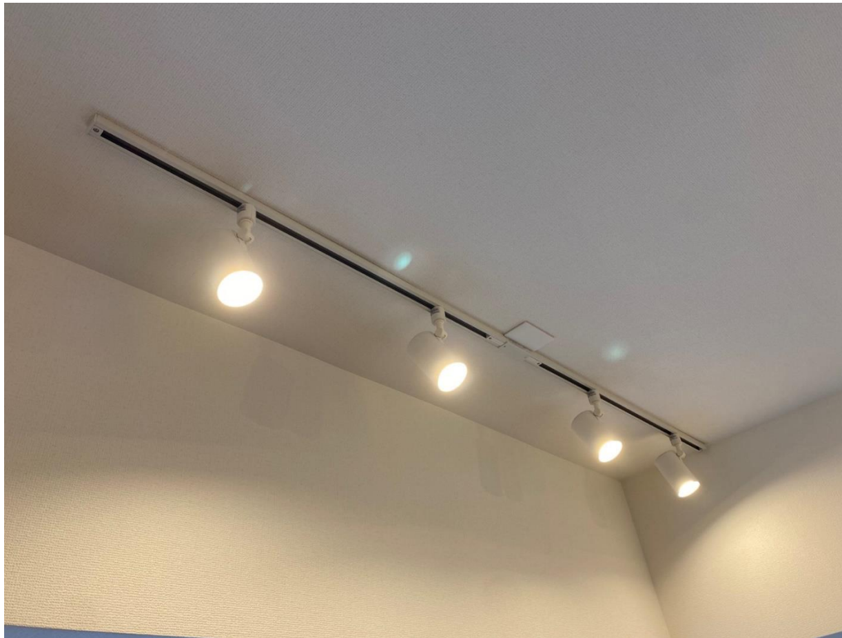
LED照明一部新設
