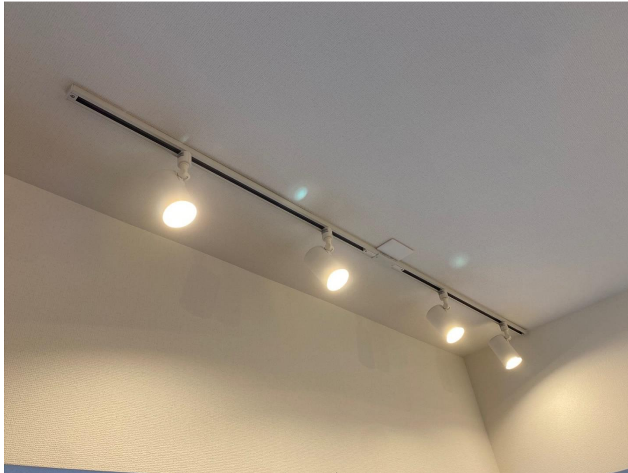
LED照明新設
