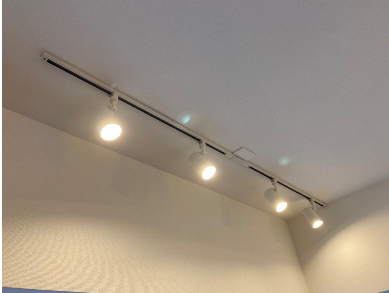
LED照明新設
