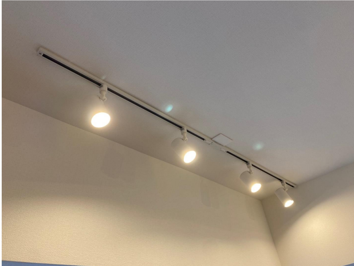
LED照明新設
