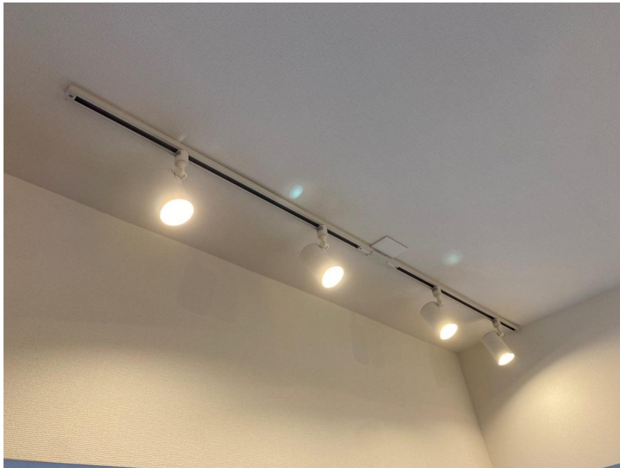
LED照明新設
