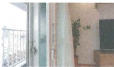
▲二重サッシ (Low-E複層ガラス) を設置
